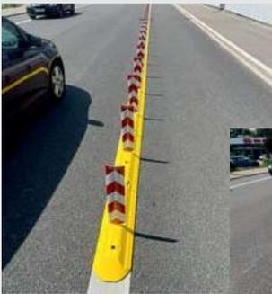
Die temporäre Lösung durch einfaches Auflegen, auch ohne verschrauben möglich.
