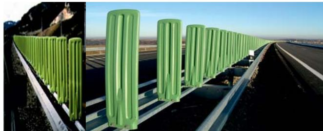
Die wirksame und unfallsichere Entblendung nach den Richtlinien des BMV sowie der europäischen Norm EN 12676-1. Das Element ist ein geblasener Hohlkörper aus HDPE: hochbelastbar, verformbar, bruchfest. Prüfzeugnis vorhanden. Mit allen Stahlteilen für jede Schutzplanke. In verschiedenen Höhen und Farben lieferbar.
