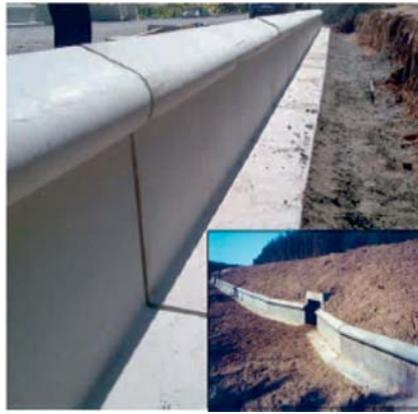
Die hervorragende Kipp- und Standsicherheit ist in der statischen Berechnung nachgewiesen. Durch L-Form werden bis zu 50% weniger Erd- und Gründungsarbeiten erforderlich. Durch Konstruktion und Betongüte verzichtet unser L-System auf Stahlarmierung, dadurch wesentlich einfachere Anpassungsarbeiten vor Ort beim Schneiden, kein Korrosionsproblem.
