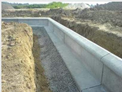
Die Beton-Leitwand erfüllt die technischen M AQ 2022 Kriterien, ist formstabil, standsicher und frost-/tausalz beständig.
