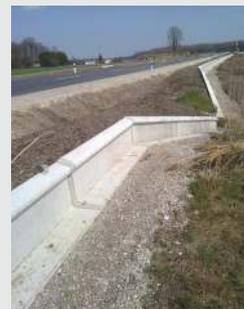
Durch das L-Element werden bis zu 50% weniger Erd- und Gründungsarbeiten erforderlich. Durch Konstruktion und Betongüte verzichtet unser L-System auf Stahlarmierung, dadurch wesentlich einfachere Anpassungsarbeiten vor Ort beim Schneiden, kein Korrosionsproblem. Unsere dauerelastische Fugenabdichtung garantiert eine absolut fugenfreie Leiteinrichtung auch bei leichter horizontaler und vertikaler Bewegung in der Fuge.
