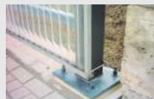
Klemmkonstruktion unten Lower clamp construction
