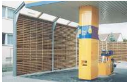
Lärmschutzwand an Tankstelle Petrol station
