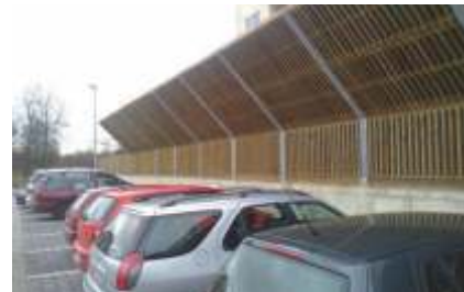
Lärmschutzwand an Supermarkt Supermarket
