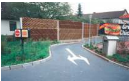
Lärmschutz an einem Schnellrestaurant Fast-food restaurant
