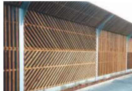
Lärmschutzwand an Parkplatzzufahrt Car park
