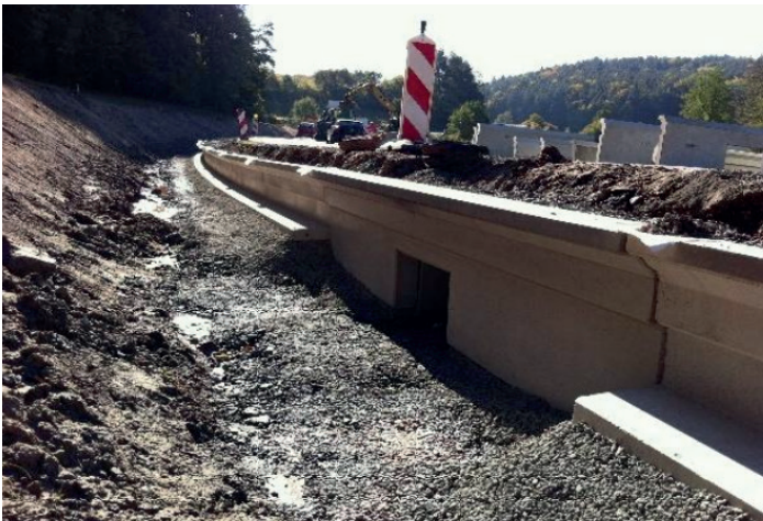
Portalelement Typ IDEAL, Betongüte C35/45; Wandstärke ab 150 mm
