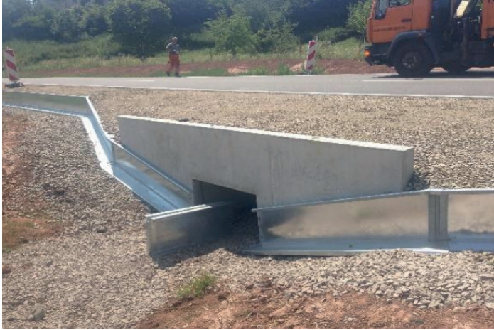
Portalelement Typ IDEAL, Betongüte C35/45; Wandstärke ab 150 mm
