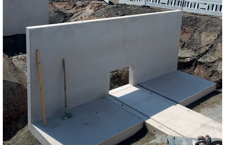
Portalelement Typ IDEAL mit Fuß, Betongüte C35/45; Wandstärke ab 150 mm
