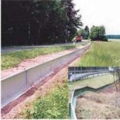
Die Amphibienprofile sind aus 60-80 my feuerverzinktem 2,5 mm Stahlblech. Zusätzlich wird eine Farbbeschichtung nach Wahl angeboten. Die Profile sind einfach und schnell aufzubauen und passen sich problemlos dem Gelände an. Die Leiteinrichtung hat eine hohe Stabilität. Form und Farbgebung lassen keine Wünsche offen.
