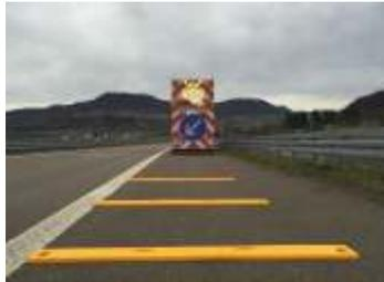
Zur Absicherung von kurzfristigen Arbeitsstellen. Erhöht stark die Auf-merksamkeit beim Überfahren, unachtsame oder übermüdete Fahrer können somit noch rechtzeitig reagieren. Hochbelastbarer Spezialkunststoff mit integrierten Glasperlenreflektoren.
