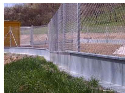
Installation sur clôtures existantes
