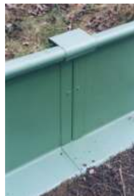
Sonderausstattung zusätzliche Farbbeschichtung mit 2 Komponentenlack und Eisenglimmer im Spritzverfahren mit ca. 120my
