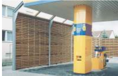
Lärmschutzwand an Tankstelle Petrol station
