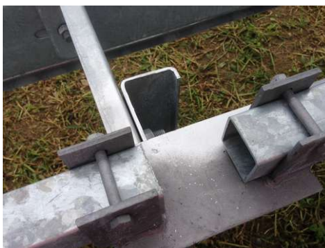
Fixation: Exemples de dispositifs pour poteaux Sigma, C 100 et sur béton
