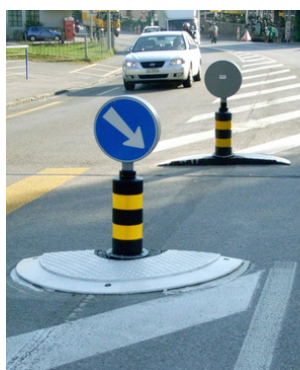
Fußgängerüberweg mit Halbinseln
